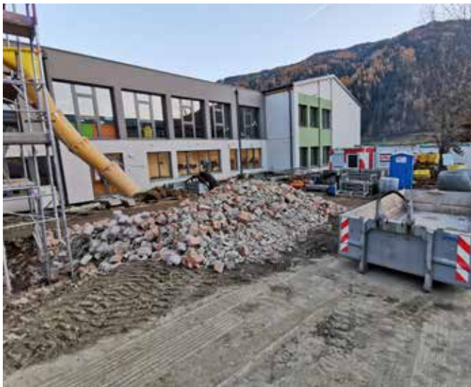
Der Platz zwischen Schulkomplex und Turnsaal wird in Zukunft durch einen überdachten Gang verbunden. Im Moment ist hier noch Baustelle.
